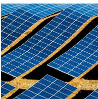
**Solar (fotovoltaica y térmica):** La energía fotovoltaica es la transformación directa de la radiación solar en electricidad, y se produce en unos dispositivos llamados **paneles fotovoltaicos**. En los paneles, la radiación solar excita los electrones de un dispositivo semiconductor generando una pequeña diferencia de potencial. La conexión en serie de estos dispositivos permite obtener grandes diferencias de potencial.
